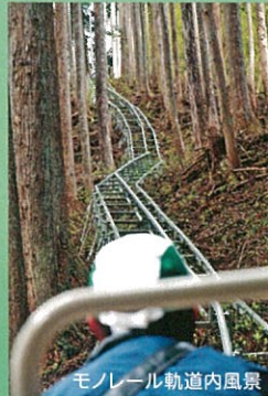
モノレール軌道内風景
