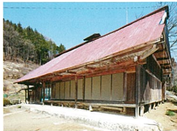
修理前の外観
