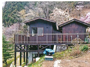
管理棟と展望デッキ
